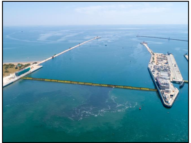
Foto 10 – Paratoie del Mose in servizio alla bocca di Malamocco
